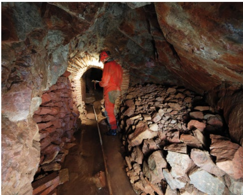
Muretes de sillarejo en el arranque de la galería "A", mirando hacia la salida (E).
