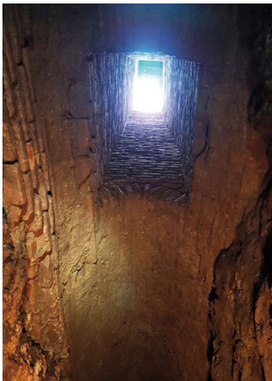
La misión de las lumbreras es airear los conductos. Detalle de la primera lumbrera del Encañado.
