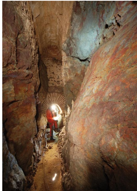
Inicio de la galería "C", mirando hacia la salida (NO).
