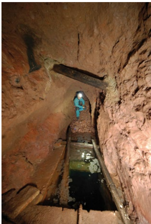
El pozo de captación principal tiene una profundidad de 6,10 m y almacena unos 16 m 3 de agua.
