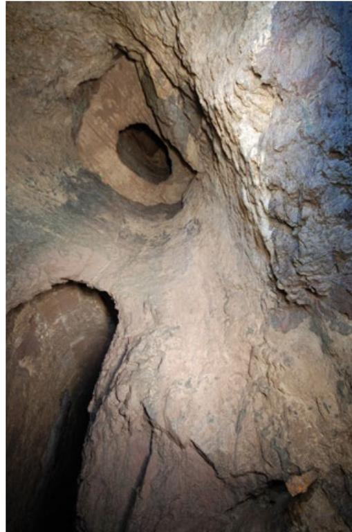
depósitos de carbonatos. Es necesario señalar también que esta lumbrera presenta dos tramos, un primero hasta una bóveda de ladrillo rota (a 3,98 m desde el suelo) y otro desde ese punto hasta el techo, situado 2,90 m por encima, donde parece que hay un cierre moderno realizado en hormigón.
