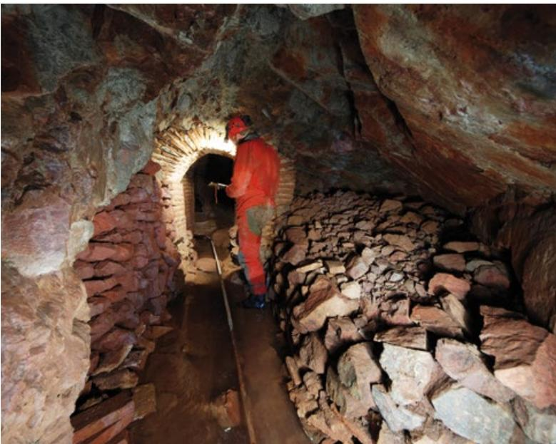
la galería de Acceso. En este espacio son apreciables en el arranque del lienzo derecho de la galería oeste (galería "A" en topografía) obras de refuerzo en el muro que se repiten también en el lienzo izquierdo de la galería este (galería "C" en topografía). Estos añadidos se aprecian más modernos y fueron acometidos con el fin de asegurar la estabilidad del conducto ante el deterioro del mismo.
