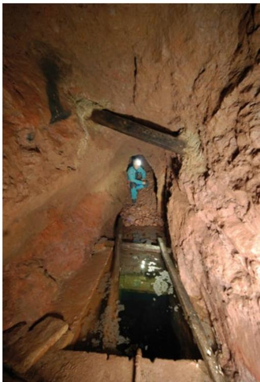
El pozo de captación principal tiene una profundidad de 6,10 m y almacena unos 16 m<sup>3</sup> de agua.
