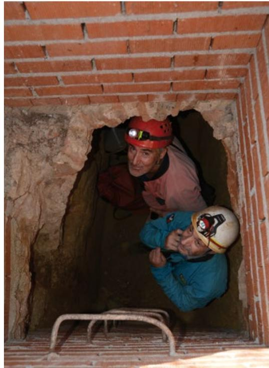
Brocal del pozo de entrada actual. La obra rompió el techo de la galería original del Encañado.
